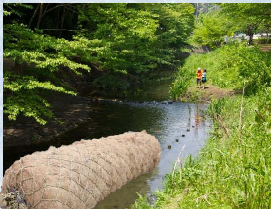
護岸改修工事で使用した資材と同様品を第2回で展示予定です。中にはヤシの繊維等が入っています。
